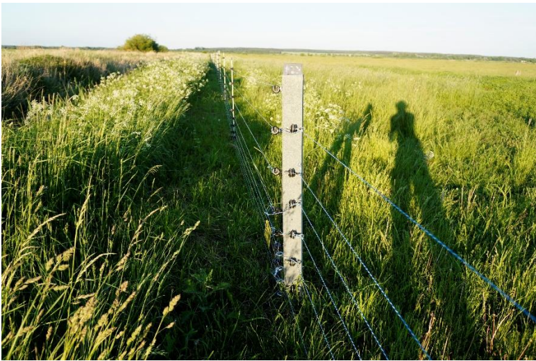
Joonis 5. Metallpostidega elektriaia näide Poolast. Sellise aia maksumus 1 m kohta Poolas koos paigaldusega oli paar aastat tagasi 7,93 eurot. Foto: Michal Korniluk.
