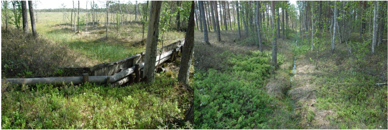
Joonis 5. Vasakul Seli Suurlauka väljavoolule rajatud laudadest tamm, paremal väljavoolukraav.
