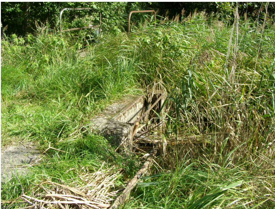
4. Kubija järve väljavoolu regulaatori ette on kobras oksi ja pilliroogu kogunud. Käsipuudega sillakese all on teine ülevool, mis taimestikku täis kasvanud. (04.09.2013).
