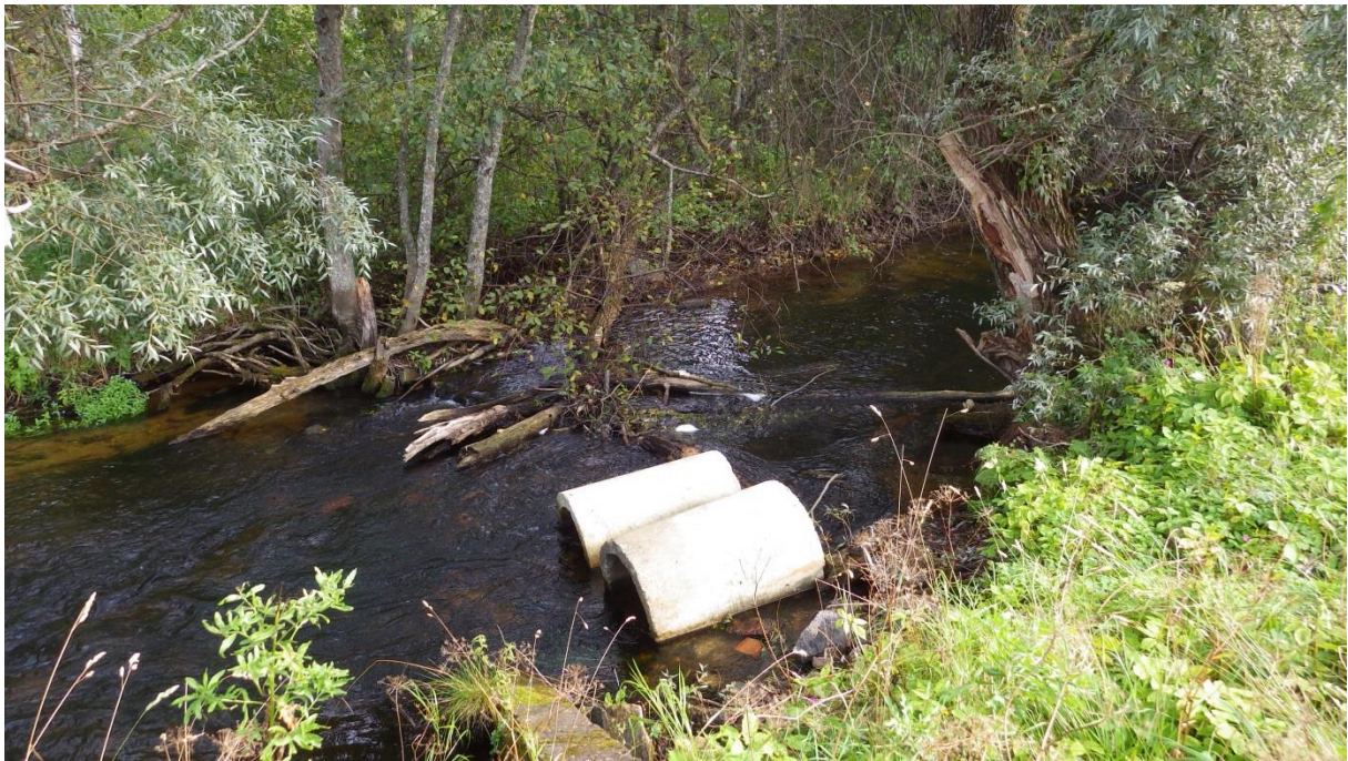
Foto 25. Vodja jõgi, suudmest 0,44 km ülesvoolu jõesängis truibitorud ja betoonitükid, 23.08.2014
