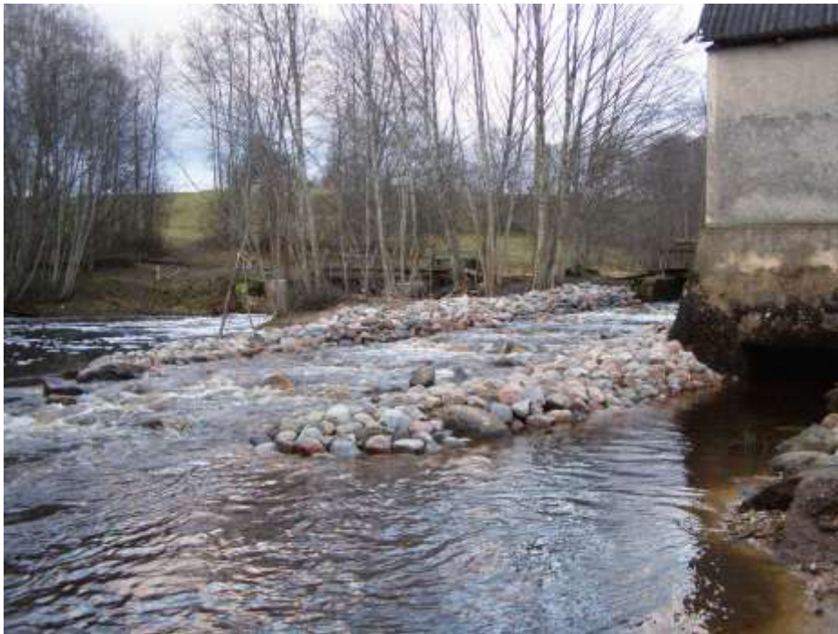
Foto 16. Vastvalminud Kaugu veskipaisu kalapääs, vaade ülesvoolu (12.11.2012).
