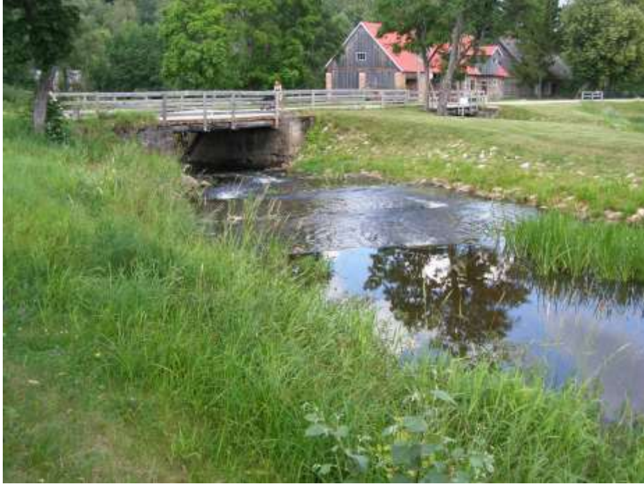
Foto 19. Sänna Alaveski paisu vasakpoolsele ülevoolule rajatud kalapääs, vaade allavoolu (10.07.2012).
